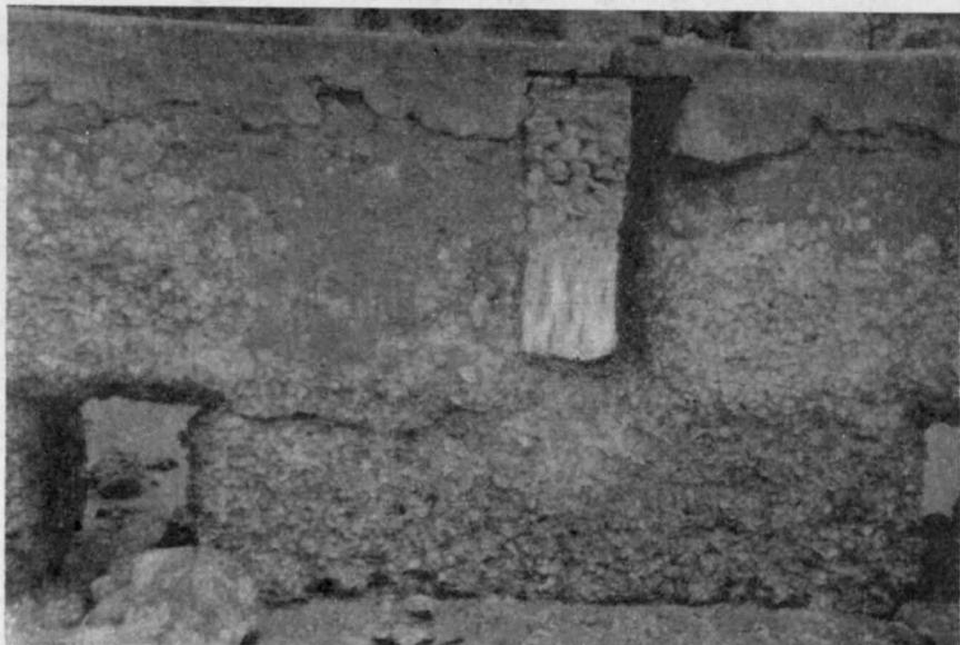
Рис. 2. Бетонный пирс, обросший баланусами и устрицами; обнажен во время отлива.
