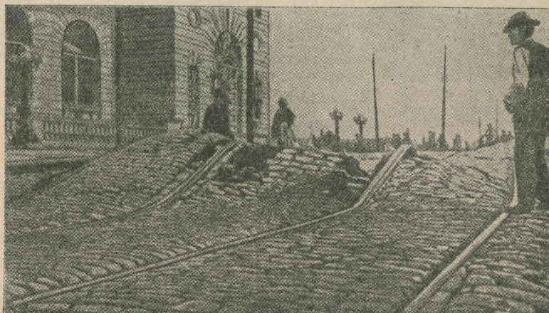
Joonis 34. Maavärinate purustused S. Franciscos a. 1906: painutatud tänavasillutis ja raudteeroopad.
