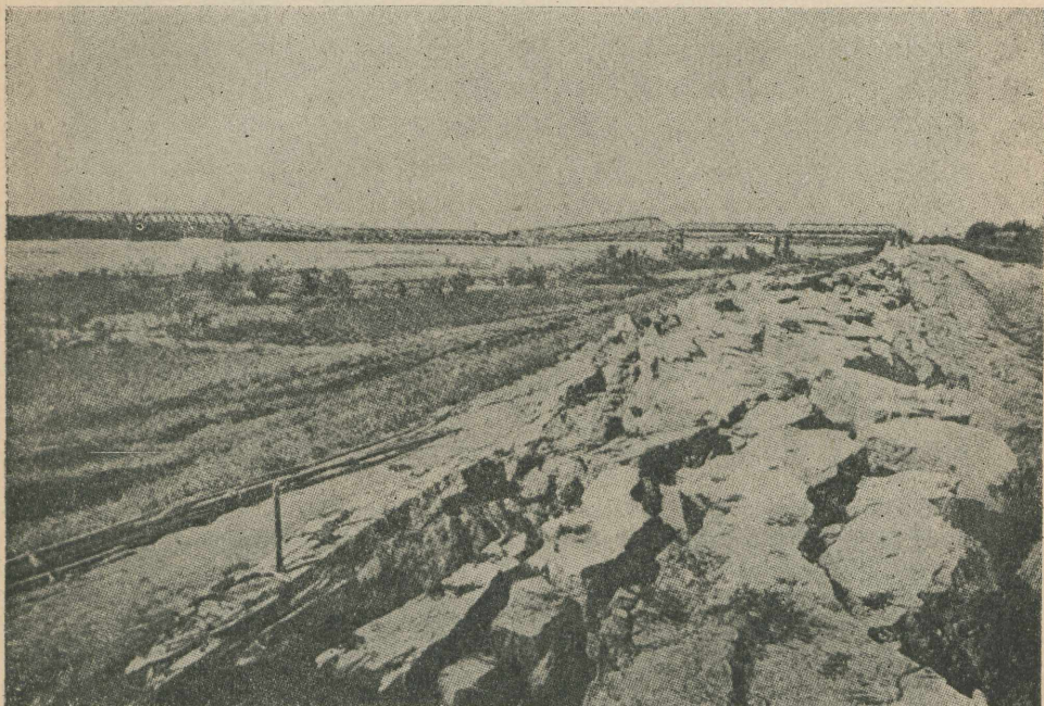
Joonis 32. Jaapani maavärin 1891. a. Lõhenenud maapind. Kokkuvarisenud sild Nagara jõel.
