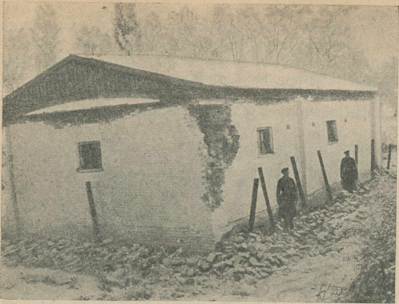
Joonis 35. Vernõi maavärin 1910: püssirohukeldri purunemine; varisesid nurgad ja side katusega.
