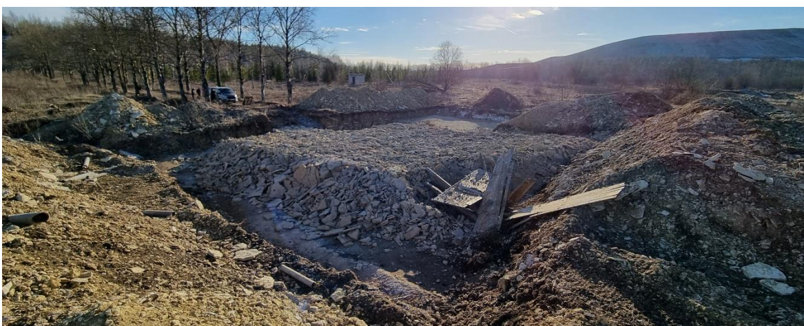
Joonis 19. Katseala peale lubjakivikonsooli puur-lõhketöödega kobestamist
