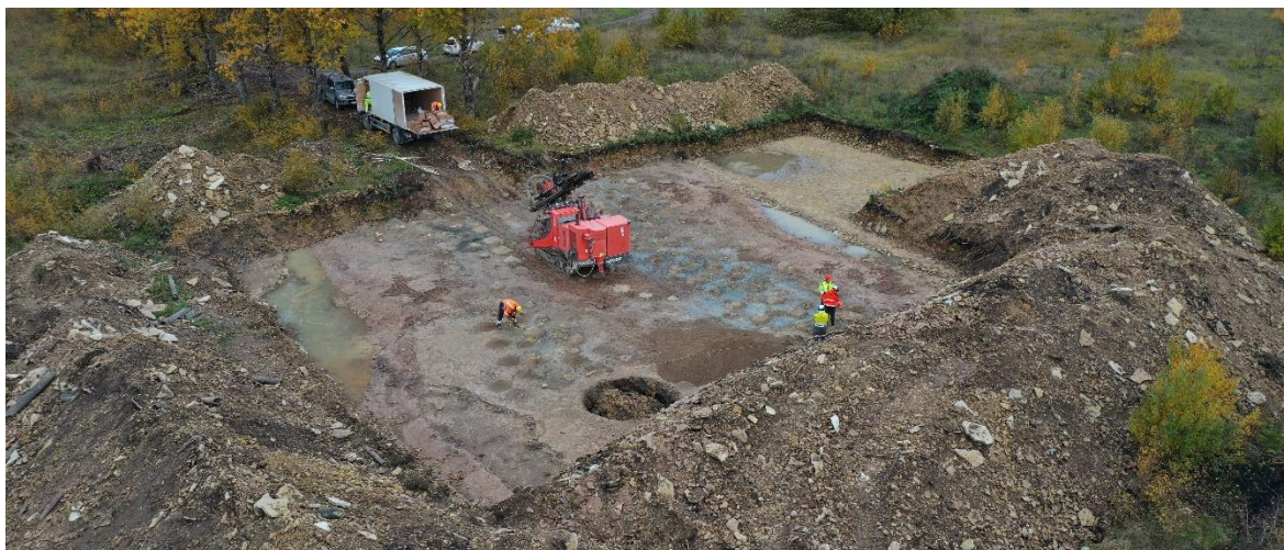
Joonis 2. Uuringutöödeks ettevalmistatud katseala
