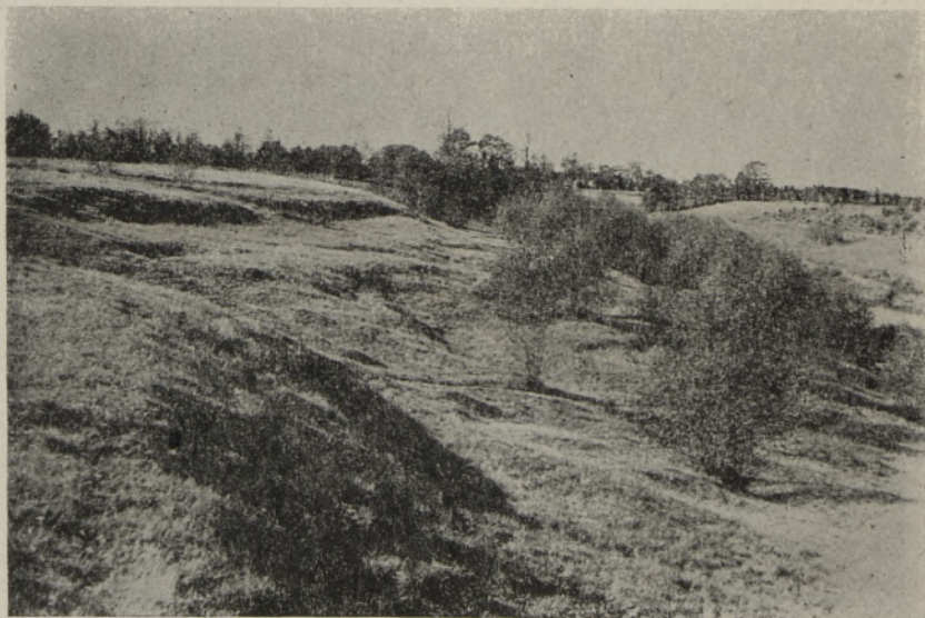
Рис. 4. Оползень на левом берегу р. Сауга.
