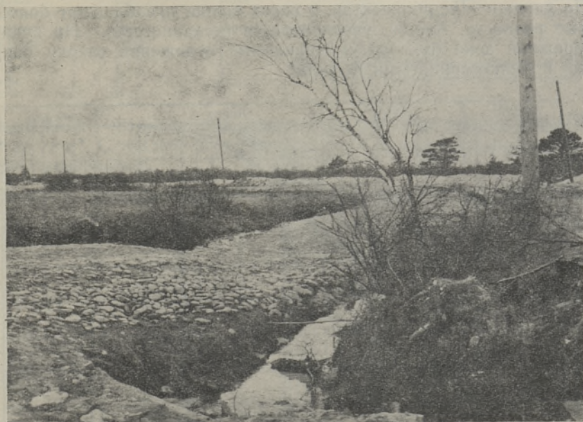
Фото 3. Оседание шоссейной дороги в результате суффозионного выноса мелкого песка из ее основания.
