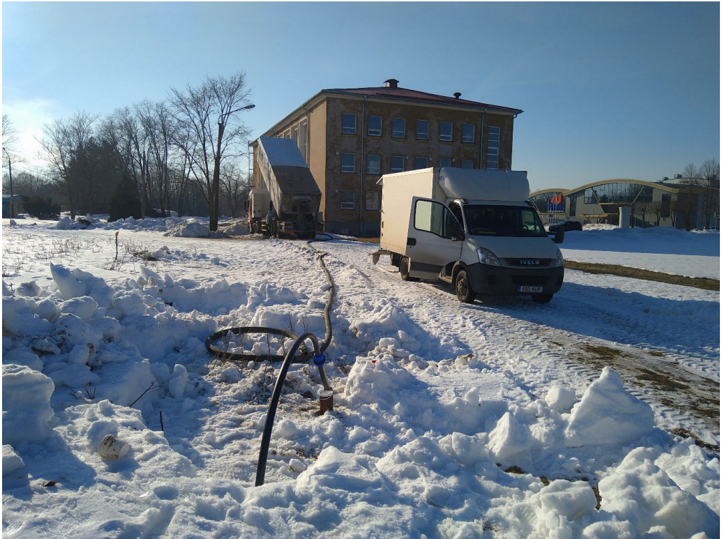
Joonis 1. Täitesegu segamine ja pumpamine kaevandusse läbi selleks puuritud tagasitäite puuraukude.
