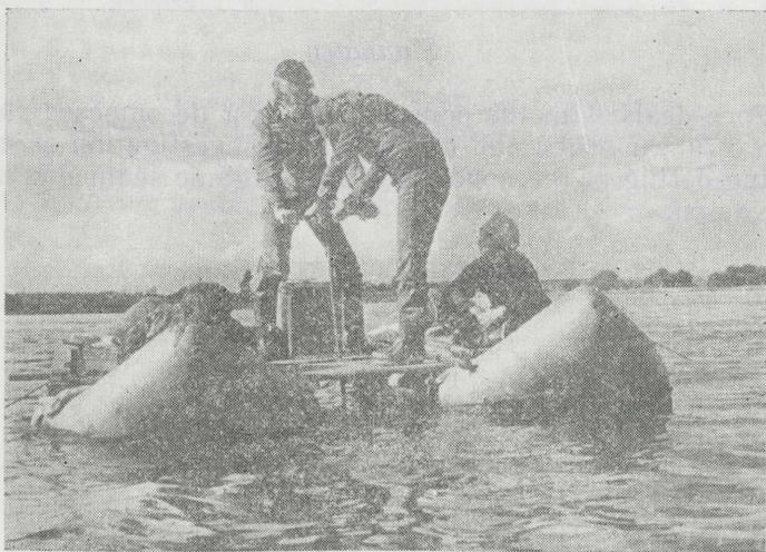
Фиг. 4. Бурение с плота-катамарана обычным буром геолога (оз. Лахепера).
